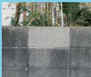
2007年1月、未施工部分と差が!
