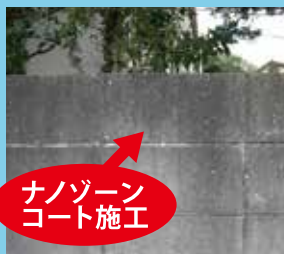
ブロック1箇所に洗浄後施工。
